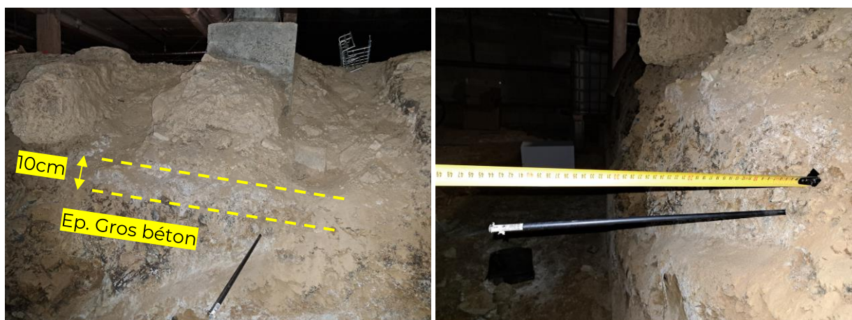
TIGE N°2 (lg :51cm) ancrée sur 6 cm sous le gros béton au niveau +0.88m/TN
